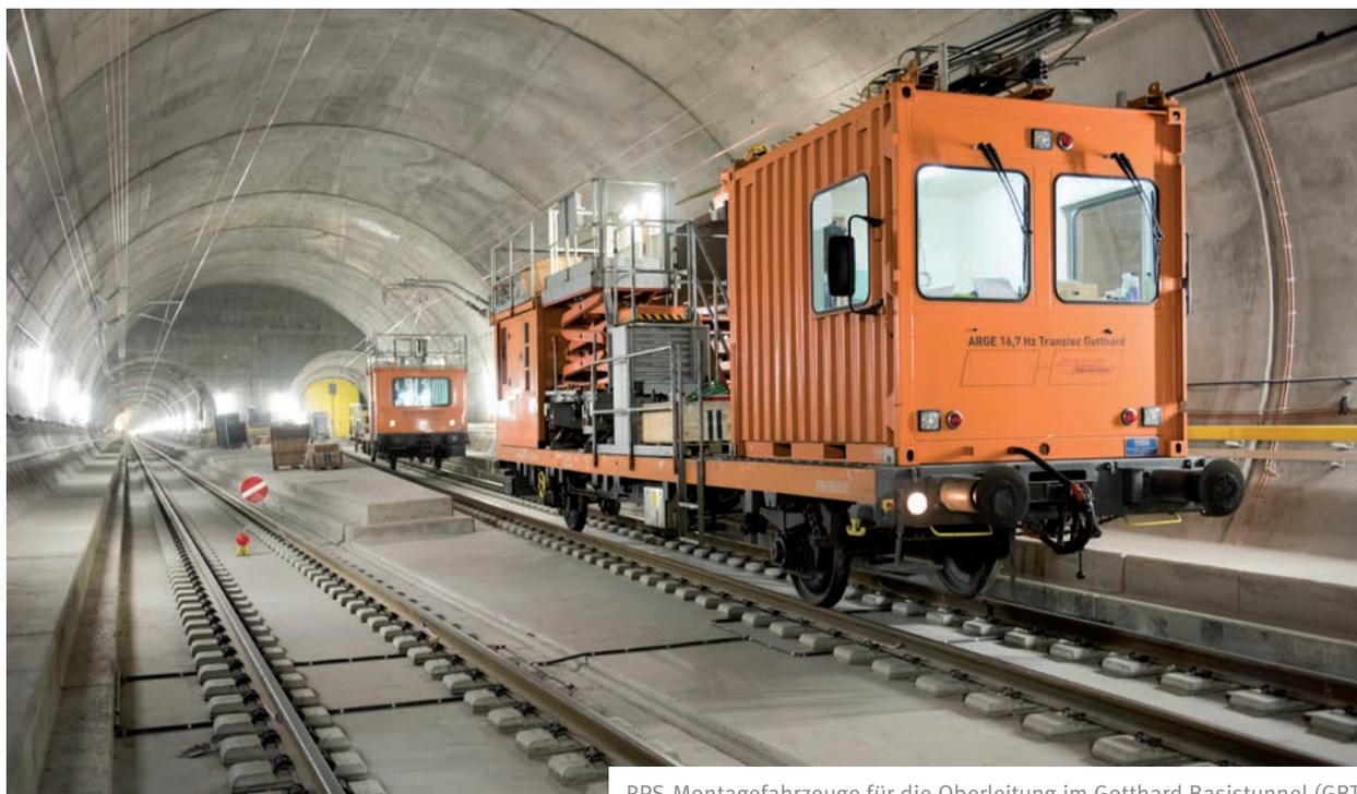
RPS-Montagefahrzeuge für die Oberleitung im Gotthard Basistunnel (GBT)
