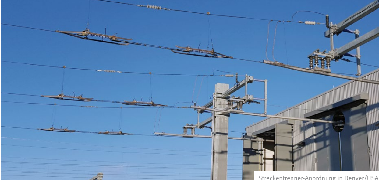
Streckentrenner-Anordnung in Denver/USA
