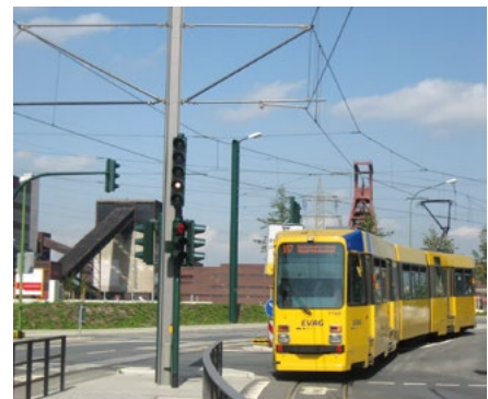
Fahrleitungsanlagen – Ausführung als Hochkette
