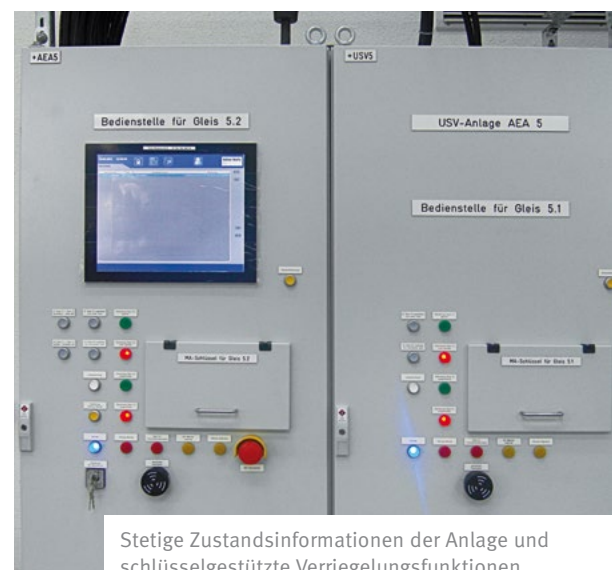
TracFeed® AEA – stellt die Abschaltung und Erdung der Oberleitung vor Aufnahme der Arbeiten sicher
