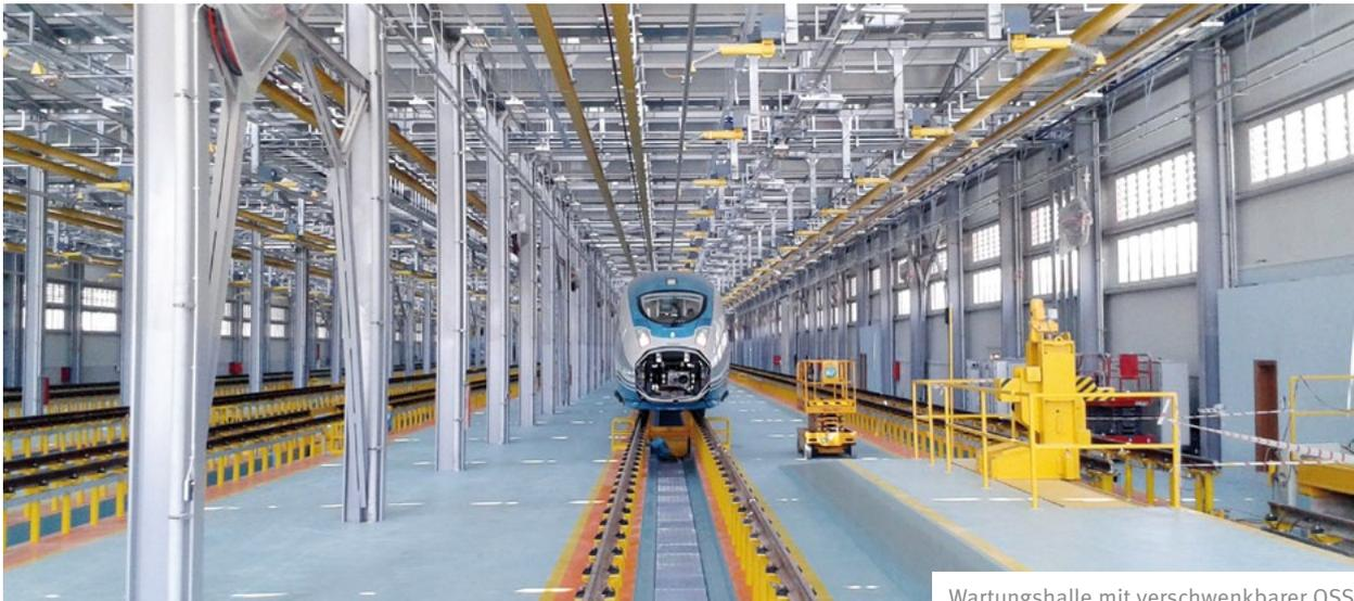
Wartungshalle mit verschwenkbarer OSS
