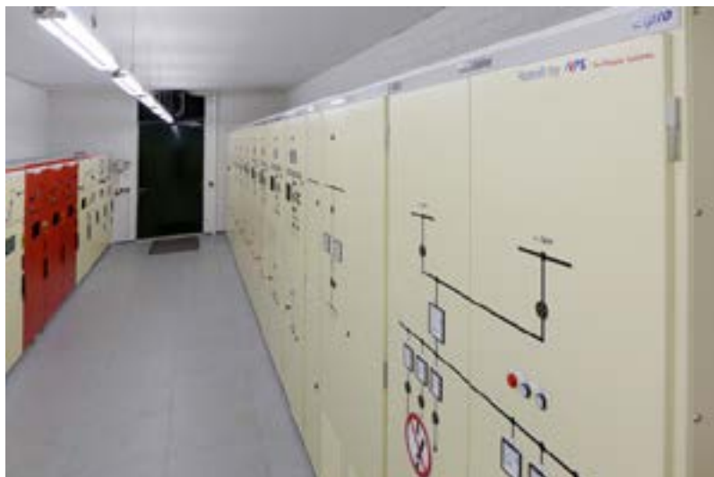
Bild 5: Gleichstromschaltanlage nach dem Umbau.
