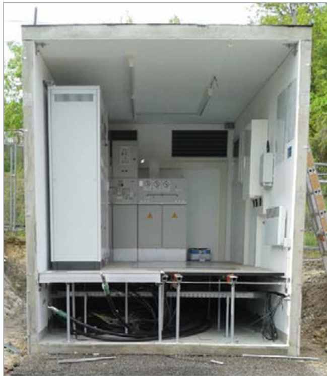
Bild 4: Gebäudeteil des G UW118 vor der Verladung am Zwischenstandort.
